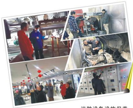
消防设备设施保养
